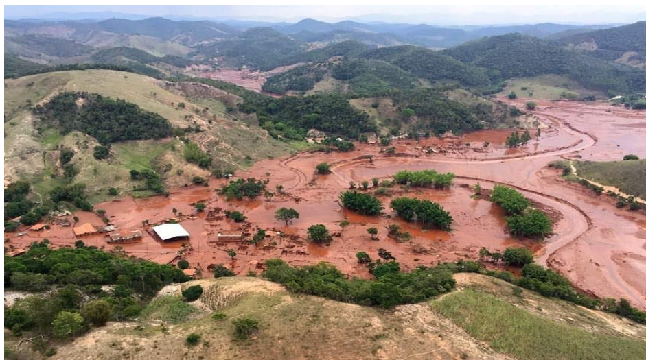
Figura 2 – Rompimento da barragem do Fundão da mineradora Samarco no município de Mariana (MG)
