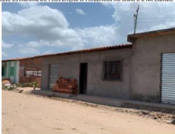
Figura 12: Casa de alvenaria
