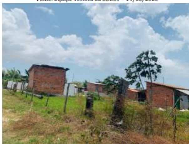
Figura 13: Casa de alvenaria
