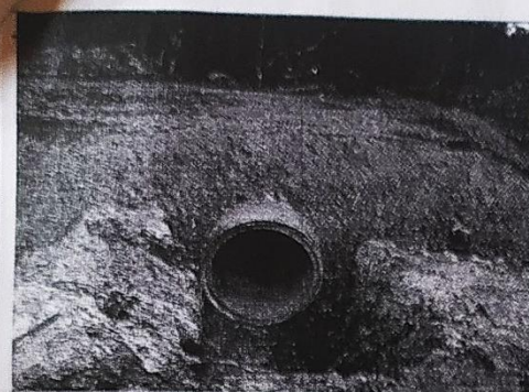
Foto 3 – Construção do Bueiro
