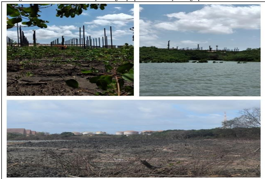
Imagem 16 - Mosaico da destruição do igarapé para a construção do galpão da Suzano
