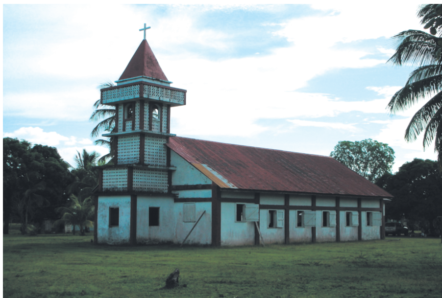
Ilustración 5.1. Iglesia morava en Tuara, vista exterior (Mark Everingham 2006).
