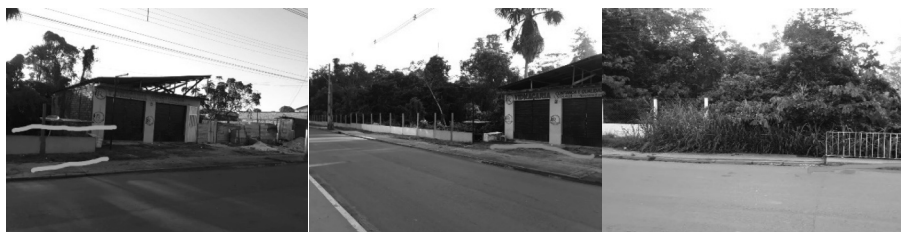
Figura 11: Muro da Prefeitura, em destaque, adiante segue Sítio Conceição. Figura 12: Em destaque início de casas do Sítio Conceição. Algumas delas tem a frente um pequeno comércio. Figura 13: Ponte sobre o rio Murucupí e mureta em construção. Fotos: José Roberto Jesus da Silva Cravo, maio, 2020.
