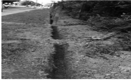
Figura 06: Escavação realizada para elevação da Mureta. Figura 7. Levantamento de colunas
