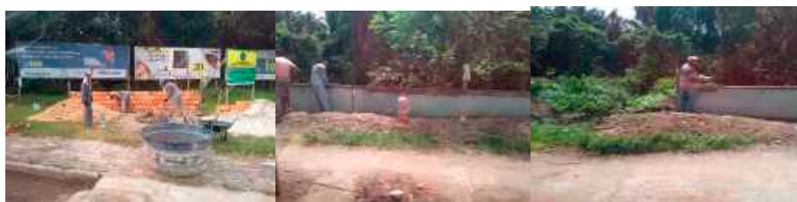
Figuras 03, 04 e 05: Pedreiros e ajudantes avançam na construção da Mureta. Fotos: José Roberto Jesus da Silva Cravo, abril 2020.
