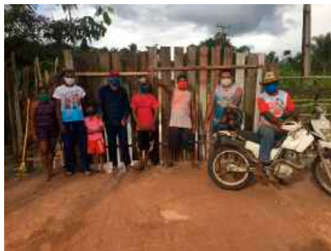
Figura 02: Instalação da Barreira em Calados, Baião. Foto: Karolaine Miranda Siqueira, quilombola de Calados, estudante de Engenharia Sanitária e Ambiental na UFPA, Campus Tucuruí, maio de 2020
