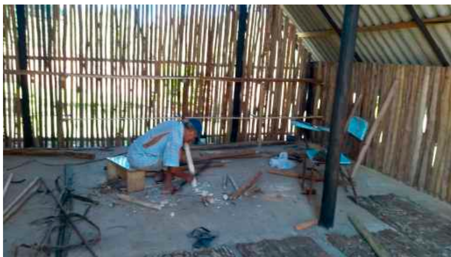
Construção do Centro de Ciências e Saberes Karapãna
