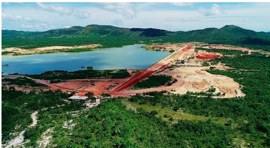
Figura 1: Vista aérea da barragem de rejeitos da ITAFÓS em fevereiro de 2019 231 .
