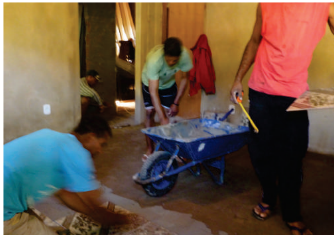
Assentando o piso na cozinha da casa de Caetano e Luzia antes do rompimento. Fonte: acervo dos moradores, sem data.
