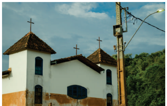
Igreja de Santo Antônio após o rompimento. Fonte: Acervo GESTA, 2017.
