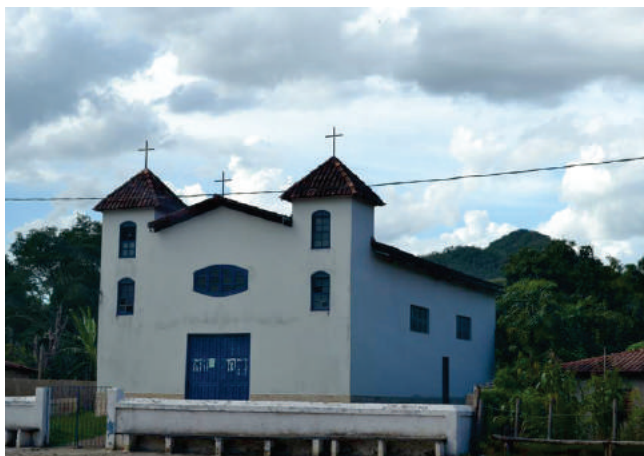
Vista da Igreja de Santo Antônio, bancos em frente à igreja. Registro antes do rompimento. Fonte: Acervo dos moradores, sem data.
