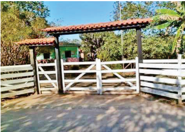
Porteira da casa de Jerônimo e família antes do rompimento. Fonte: acervo dos moradores, sem data.
