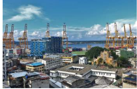
Instalaciones portuarias en Buenaventura.
