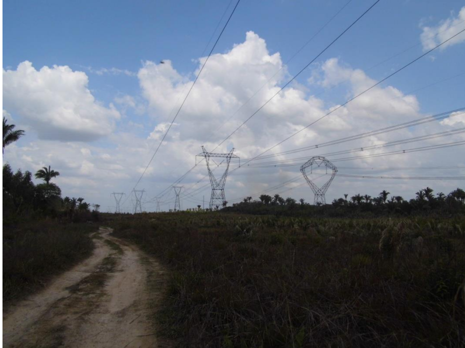
Figura 12. Linhões de energia da Eletronorte, que atravessam o território de Santa Rosa dos Pretos Foto: Zica Pires 2018.
