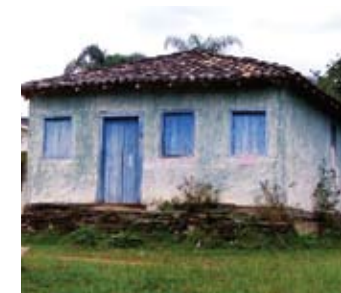
Casa de morador
