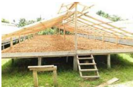
Galpão Secagem de Castanha na APROCAM
