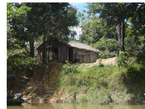
Residência do Cujubim Beira Rio
