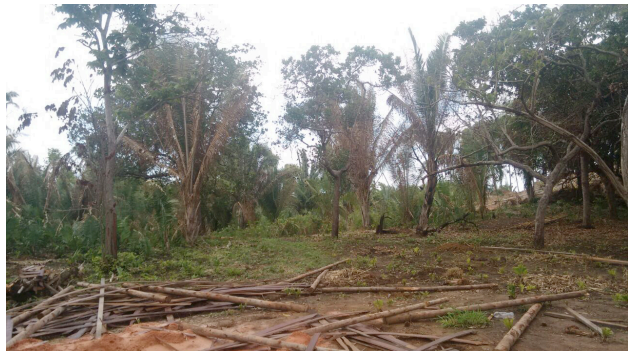
Casa derrubada no Cajueiro, janeiro de 2017.
